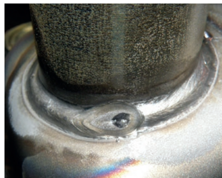
Cordón de soldadura después de la limpieza con agua a alta presión
