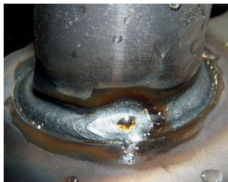
Cordón de soldadura antes de la limpieza con agua a alta presión
